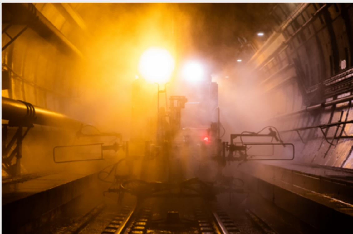
Opération de nettoyage à l'eau du Tunnel
